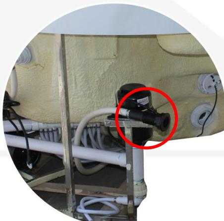
Fig. 17 – Vista linea di scarico vasca con valvola di non ritorno
